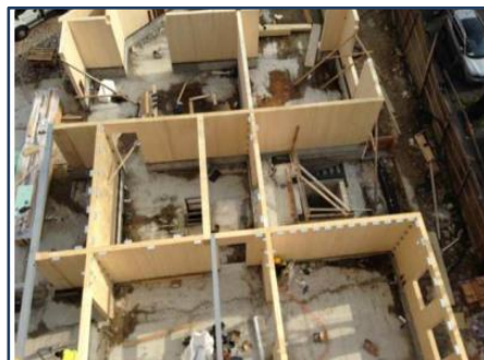
DURANTE I LAVORI
