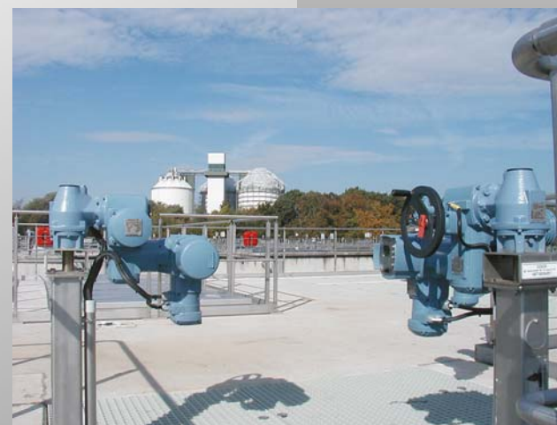
Attuatori elettrici a FO installati in un depuratore acque reflue con digestore anaerobico
