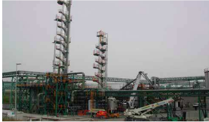
Fig.4 Fase realizzativa dell'impianto Pilota
